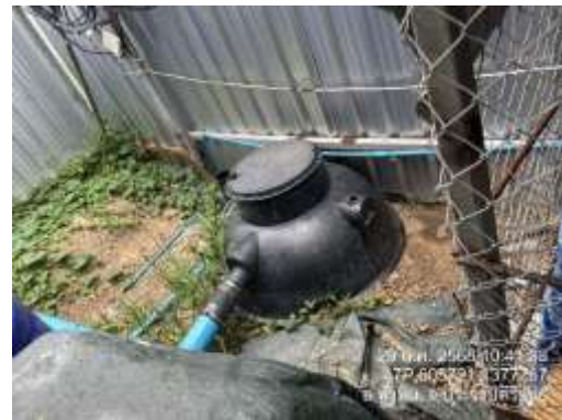
รูปที่ 21 ถังบำบัดน้ำเสียสำเร็จรูป
